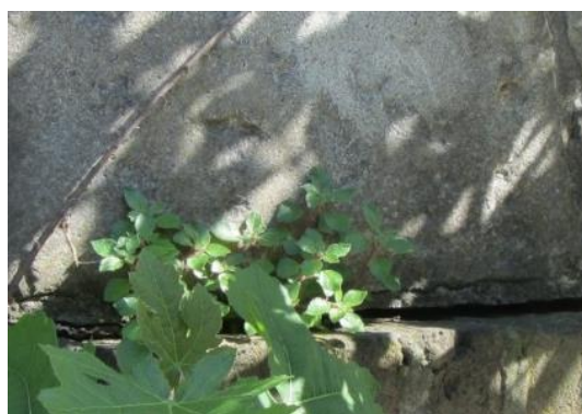
PARTICOLARE DELLA FESSURA PRESENTE ALLA BASE DEL RIALZO DEL MURO SPONDALE
